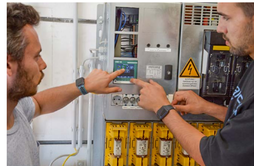
Kollegen der e-netz beim Einbau von Multimessgeräten im Rahmen des Projekts NeNa.
